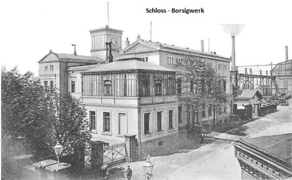
Hier ist das Institut eingezogen (Bruders Arbeitsplatz)
