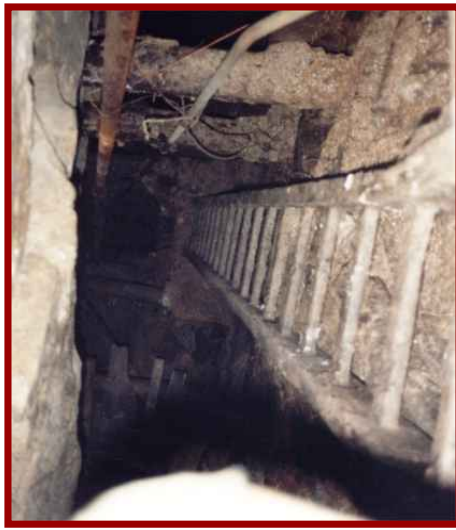
Die Leiter in die Tiefe des Schachtes.
