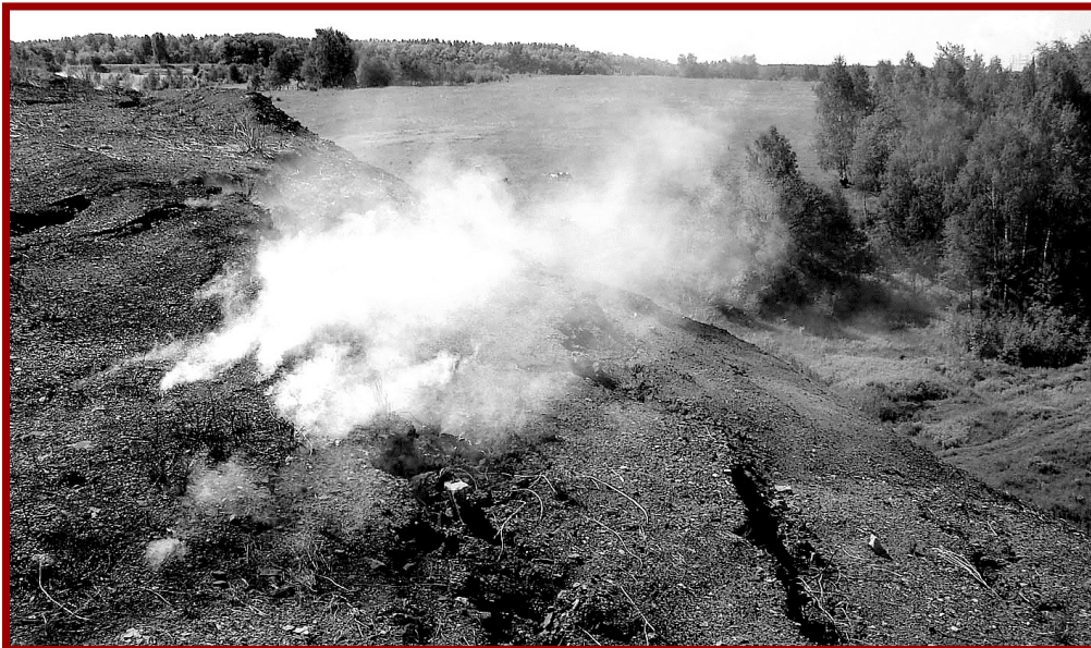
Die Halde heute (10.2006). 30 Hektar groß, davon 6 Hektar brennend. Sonden-Messungen haben in der Tiefe Temperaturen bis 600 ° C ergeben.
